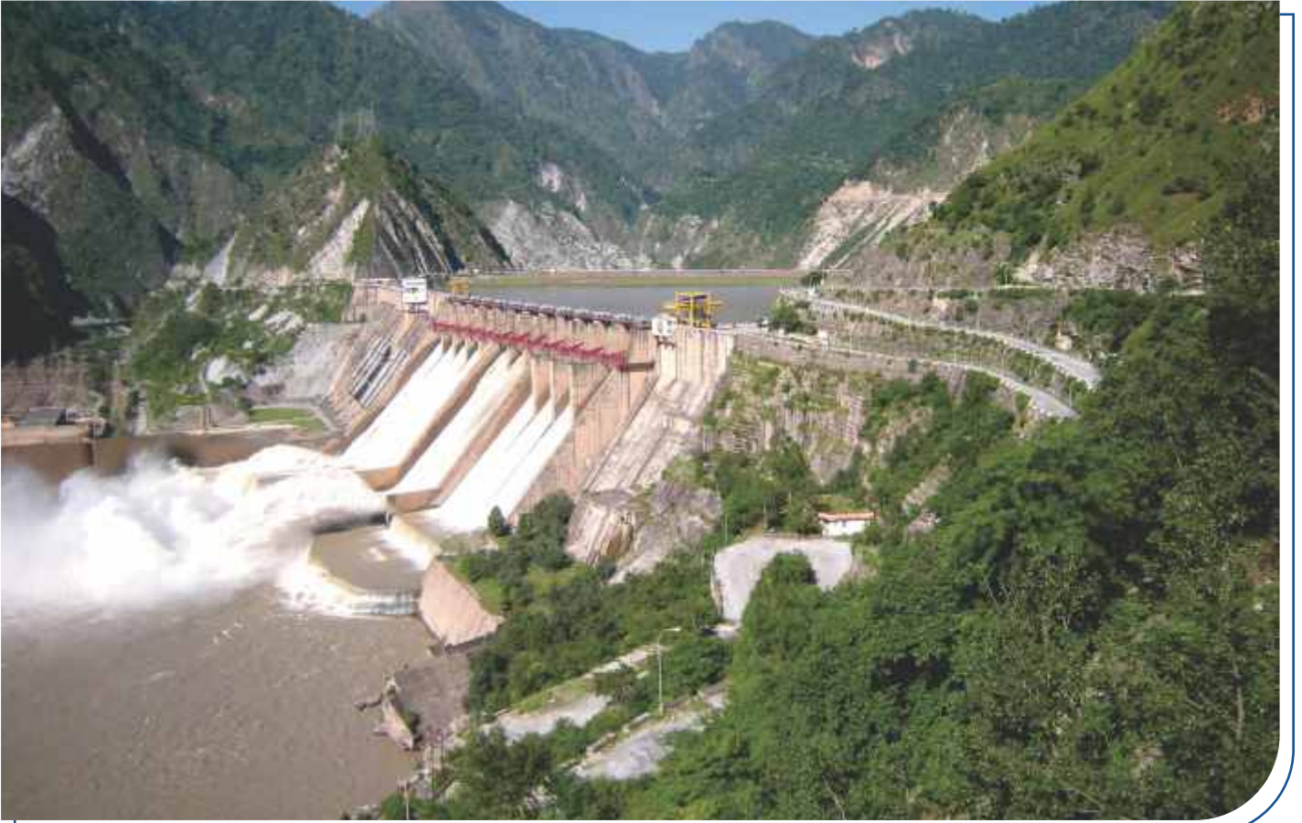
एनएचपीसी-690 मेगावॉट सलाल पावर स्टेशन (जम्मू एवं कश्मीर)-बाँध
