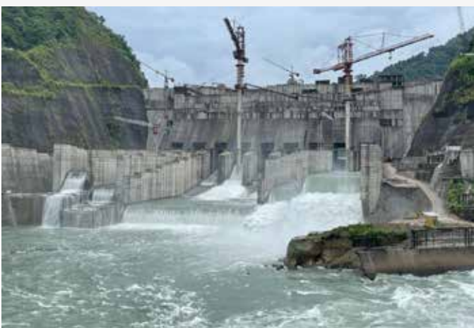
SUBANSIRI LOWER H.E. PROJECT (DAM VIEW)
