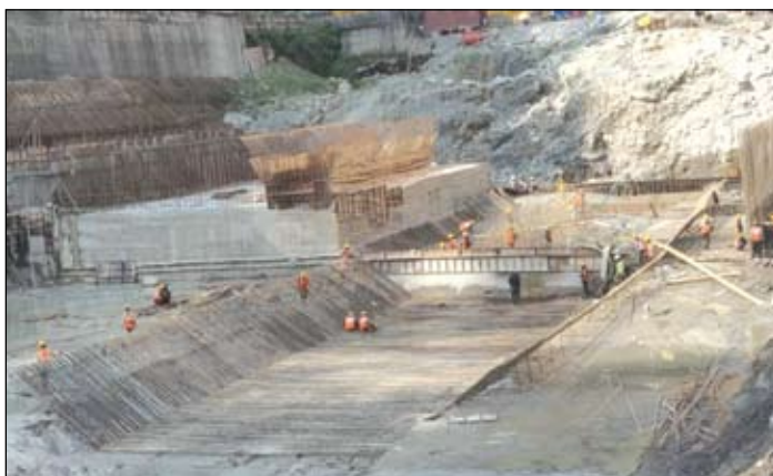
Barrage Construction - Teesta VI H.E. Project
