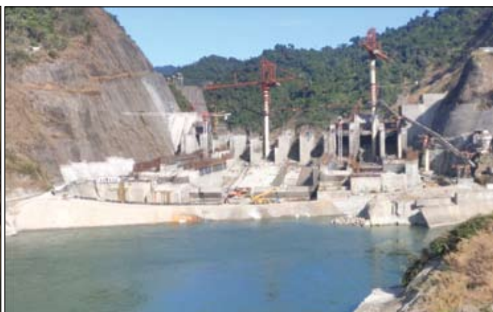
Dam – Subansiri Lower
